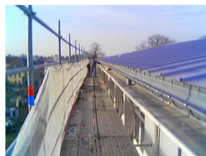
Pendant les travaux – début 2006
