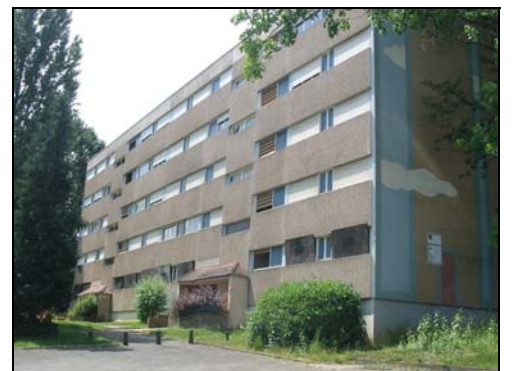
Immeuble, allée des Glaïeux (démolition)
